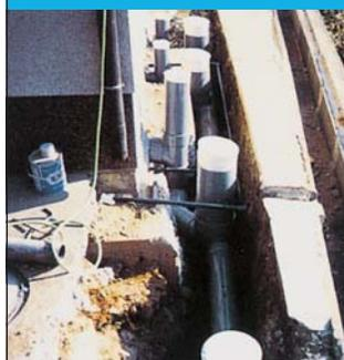
排水管、ますを設置し、台所、風呂、洗面所等の排水出口と接続します。
