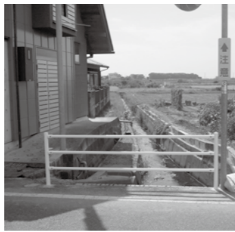
▲ 浸水対策工事を行います
