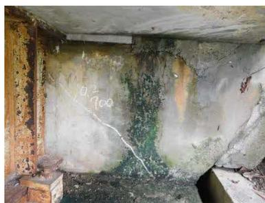
下部工にひび割れが見られます
