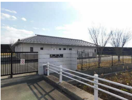
図 2-7 印西クリーンセンター
