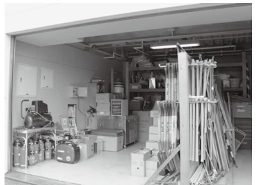
急がれる災害備蓄倉庫の建設
