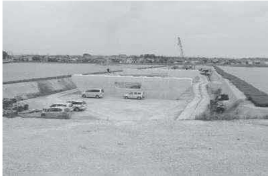
橋脚工事が進む天満大池バイパス
