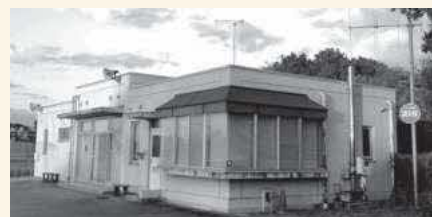
トイレ改造工事を行うサン・スポーツランドいなみ
