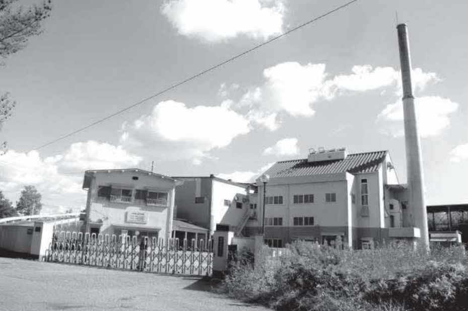
業務を終え解体工事を待つ清掃センター
