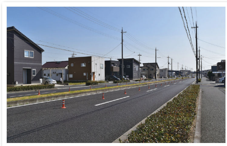
土地区画整理事業で整備された住宅地区
