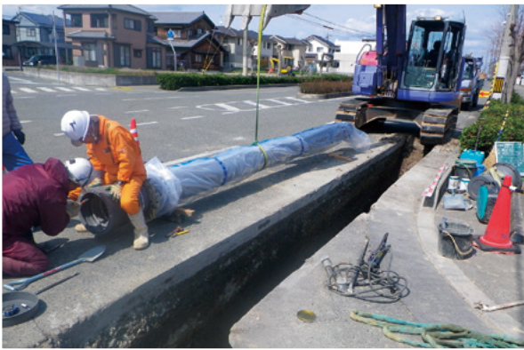
老朽管更新工事
