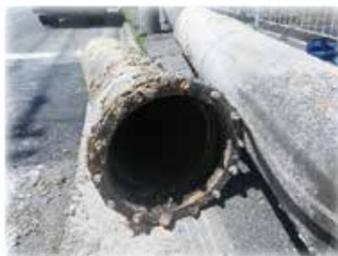
老朽化した水道管(口径500mm)
