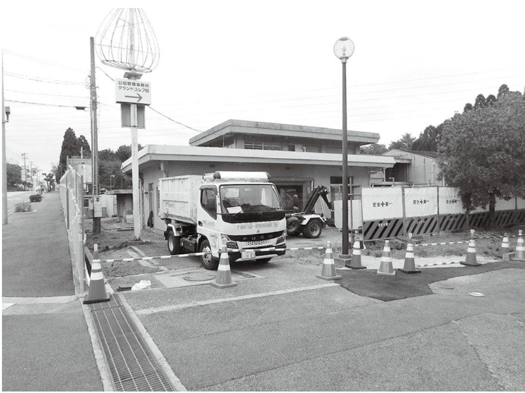
西部配水場 第1配水池の改築工事（国安地内）
