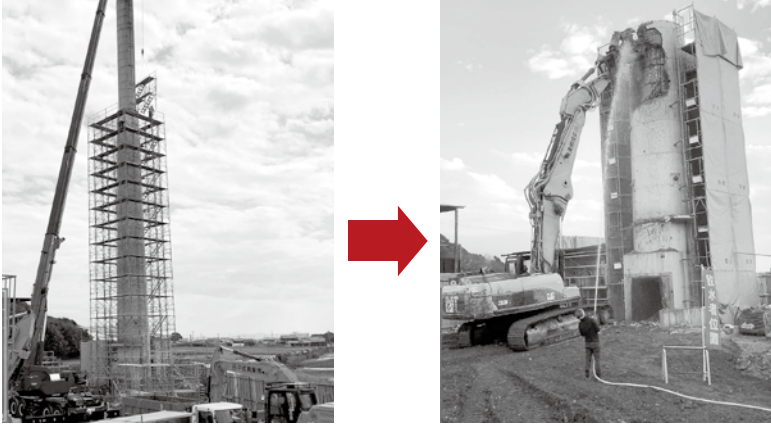
解体撤去工事が進む清掃センター（左：5年9月撮影 右：5年12月撮影）
