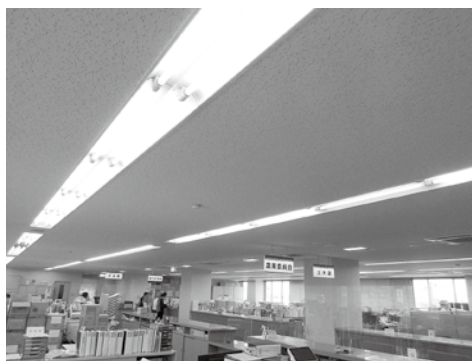
LED化等が予定されている庁舎新館
