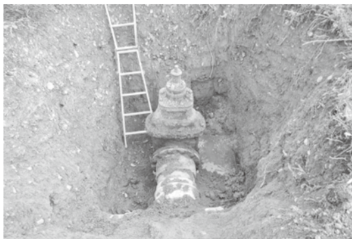
更新されるパイプラインのバルブ（草谷川地区）
