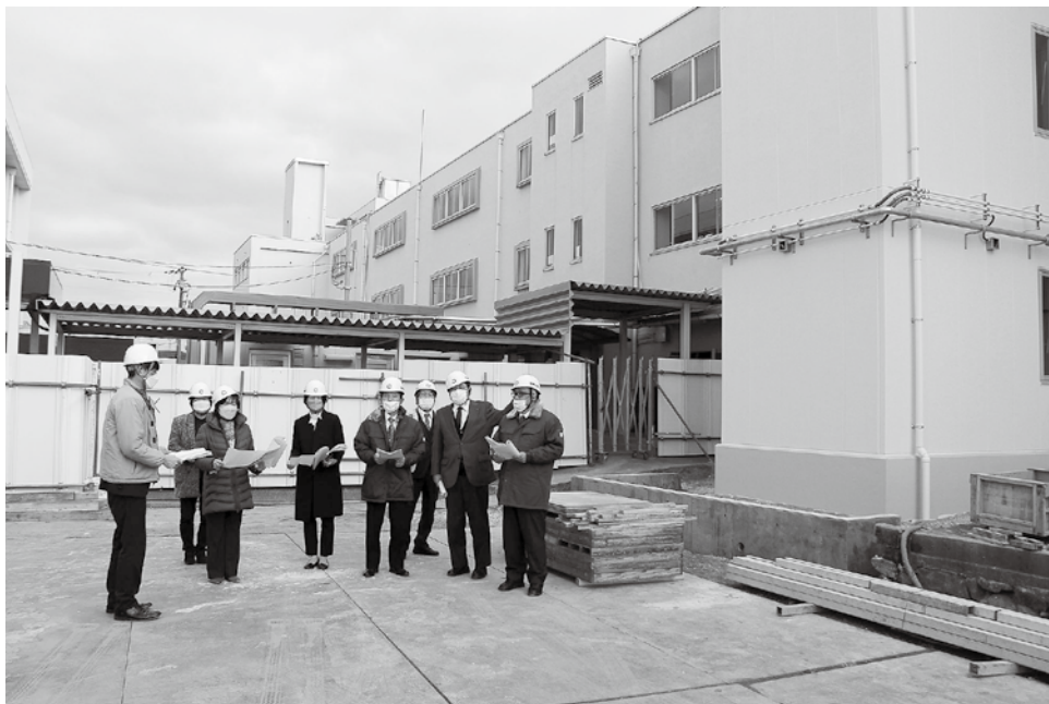
母里小学校のエレベーター設置工事を現地調査
