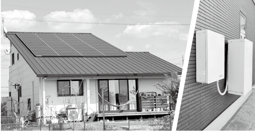
太陽光発電システム（左）と蓄電池システム（右）
