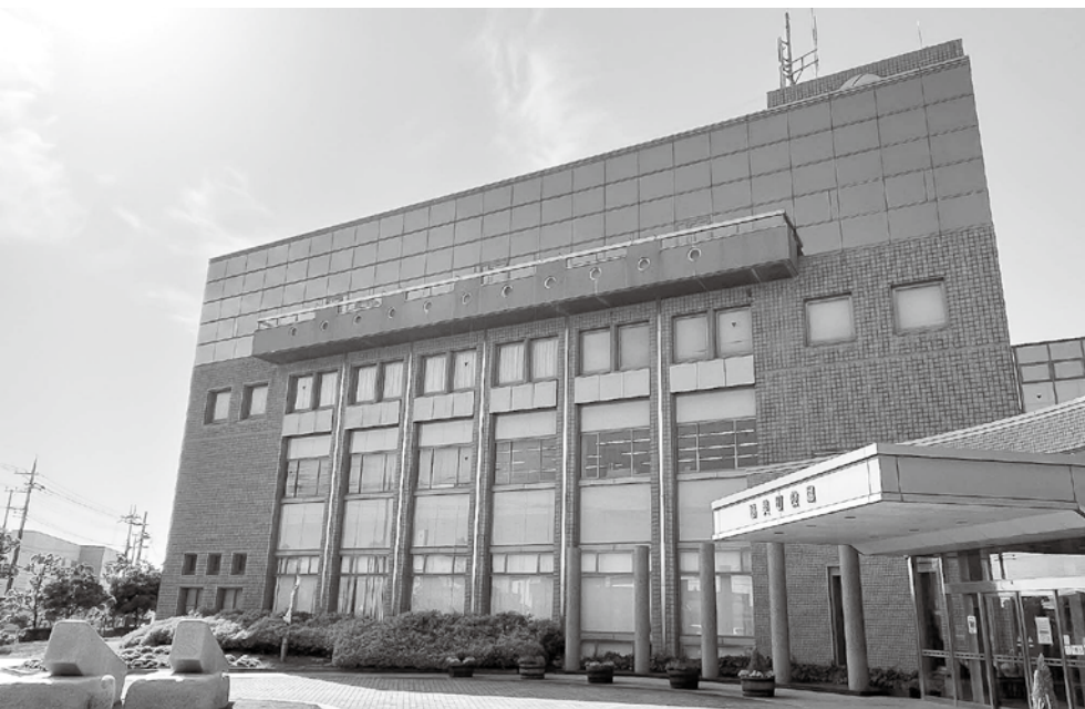
改修される庁舎新館
