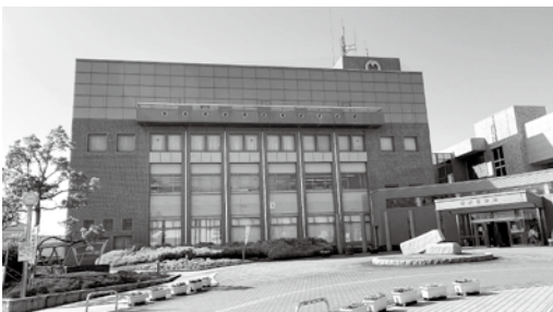
改修される役場庁舎新館
