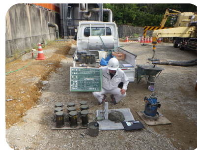
げんば うけいれけんさ ようす 現場での受入検査の様子
