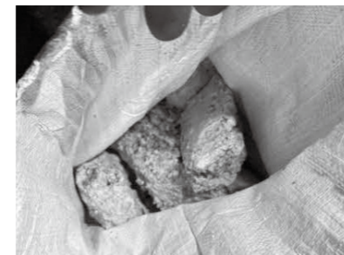
▲油類が下水道管内で硬化したもの
