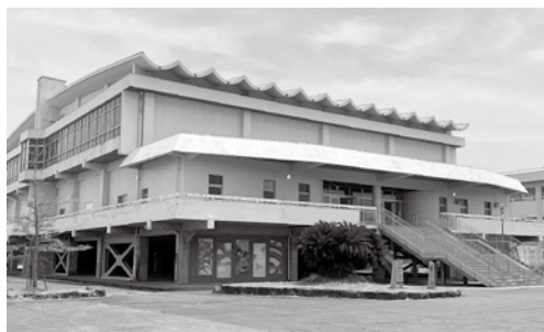
空調機設置を待つ稲美中学校体育館
