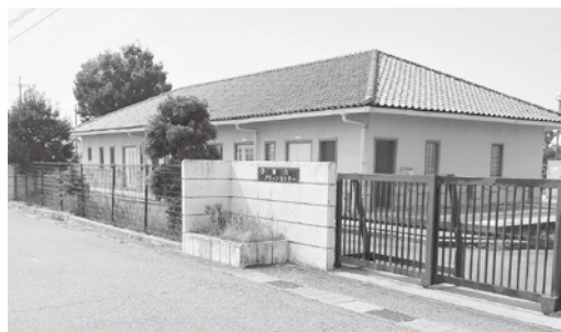
農業集落排水施設（加古クリーンセンター）
