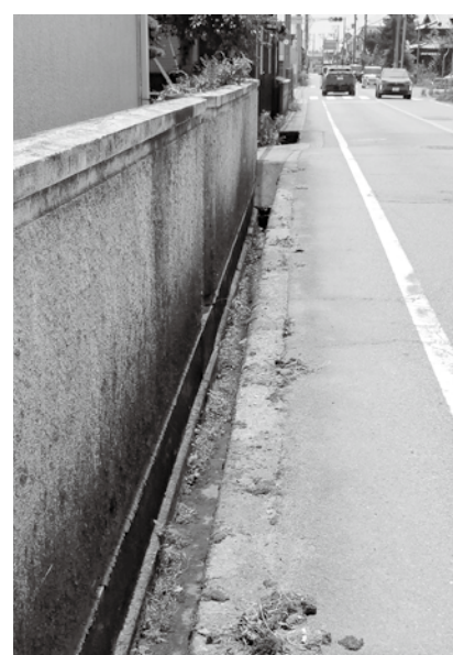
県道沿いの側溝
