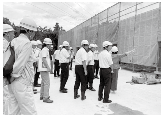
現地調査をする委員（西部配水場）
