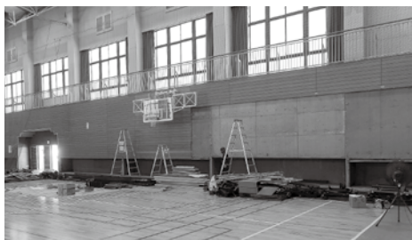
空調設備設置工事が進む「いなみ野体育センター」
