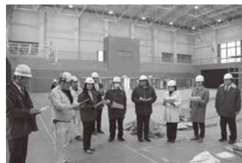
空調設備設置工事の様子を現地調査する委員
