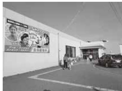
大改修が行われる「いなみアクアプラザ」
