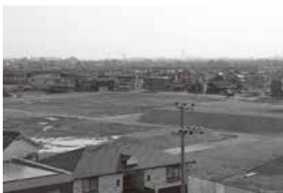
工事が進む役場西地区の工場跡地
