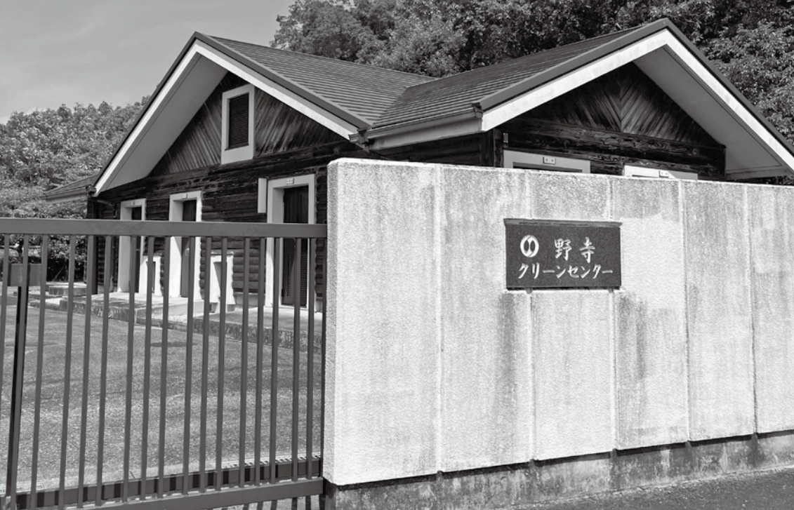
公共下水道に統合される農業集落排水（野寺クリーンセンター）
