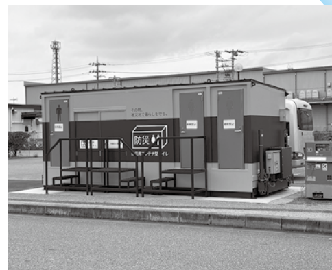
防災コンテナトイレ (沖縄県糸満市 糸満道の駅)
